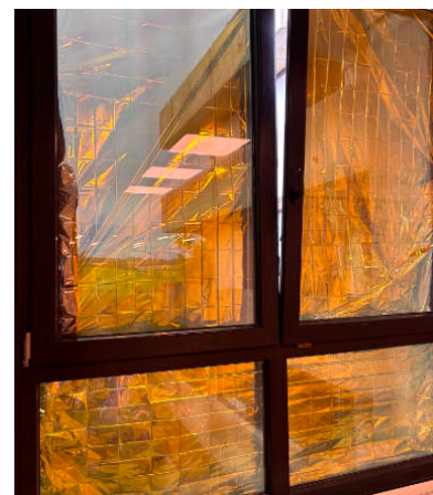
Couverture de survie sur les fenêtres d'un hôpital en Wallonie. Photo : PwG.
